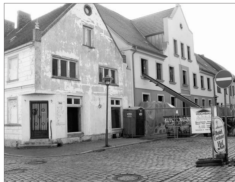
Mit dem Abriss des alten Eckgebäudes am Usedomer Markt verschwindet ein weiterer Schandfleck aus dem Zentrum. OZ-Foto: I. N.
